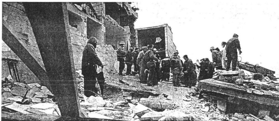
CARLENTINI, I DANNI DEL TERREMOTO DEL 1990
